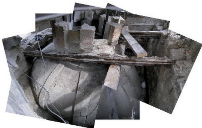
Los casquetes S3, S4 y S6 se deformaron del mismo modo aunque con diferentes valores; 3 cm, 3,5 cm y 7 cm respectivamente. El resto de casquetes se deformaron con un desplazamiento horizontal hacia el exterior de la sección inferior, acompañado de un descenso de la mitad superior. En este caso, el casquete más deformado es el S5, con desplazamientos de hasta 6 cm.
